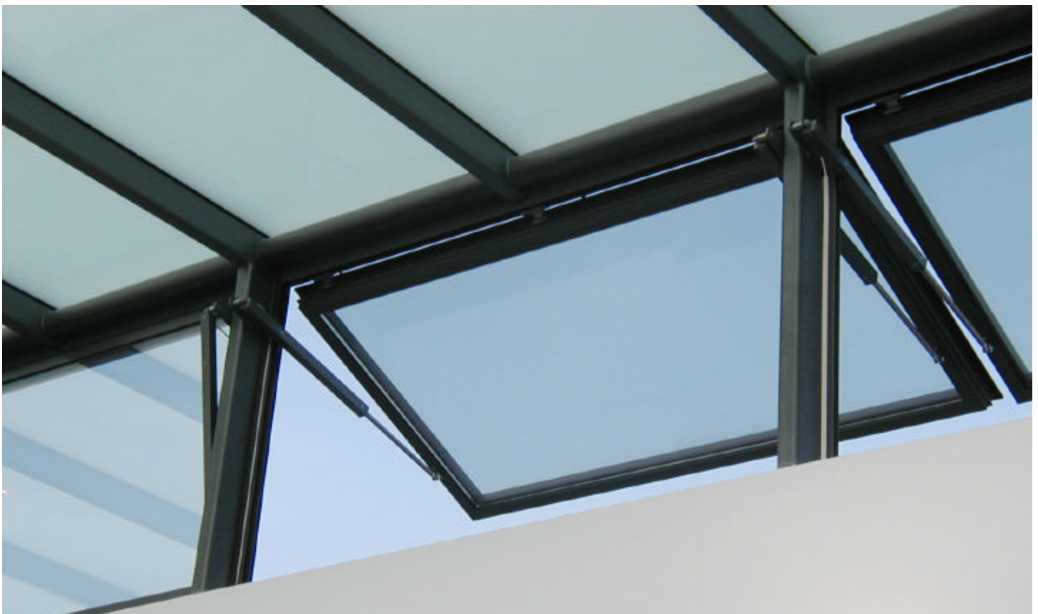
16 RWA-Flügel „Klappflügel unten auswärts“ über 70° Optimal wirksamer Rauchabzug durch günstige Einbausituation und Öffnungswinkel
