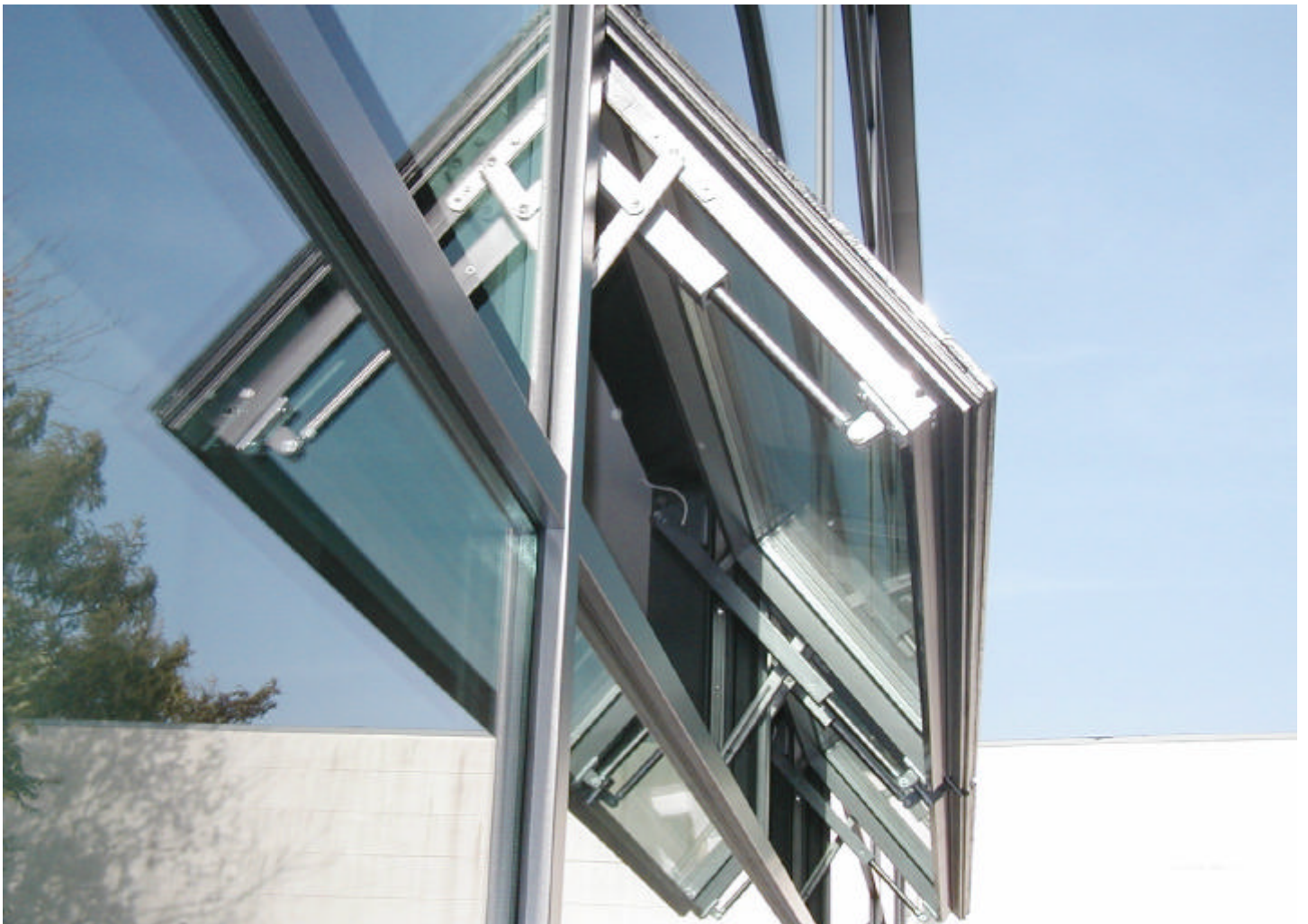
30 RWA-Flügel „Senk-Klappflügel“ unten auswärts öffnend mit WERO-Spindelantrieben SG 50-35
