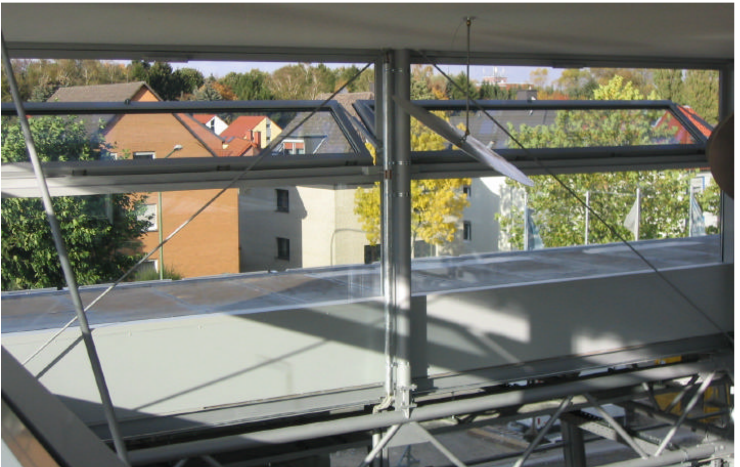
8 RWA- und Belüftungsflügel Flügelgröße: 3300 x 720 mm Öffnungswinkel ca. 60 ° gem. Brandschutzgutachten 2 Antriebe pro Flügel mit zusätzlicher Motorverriegelung oben mittig
